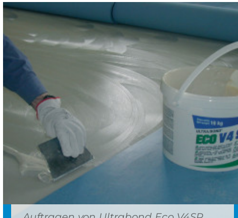
Auftragen von Ultrabond Eco V4SP im San Martino Altersheim – Italien
