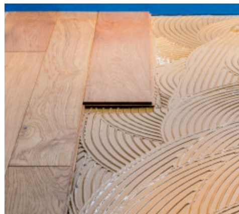
Verlegung von Parkett
