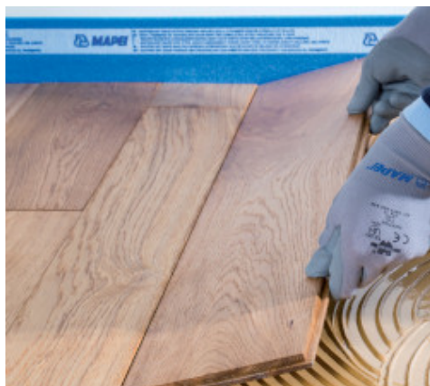
Verlegung von Parkett
